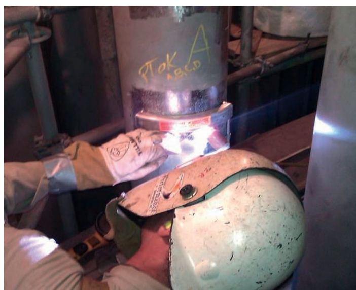
Especialistas qualificados para instalação de termopar para superfície de tubo
